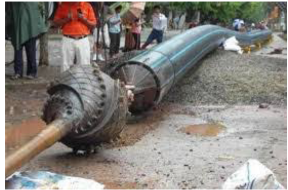
Hình 3.8. Mũi khoan nối với ống trước khi kéo ống [8]
