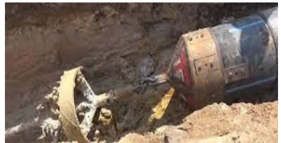
Hình 3.9. Ống được kéo vào lỗ khoan [8]
