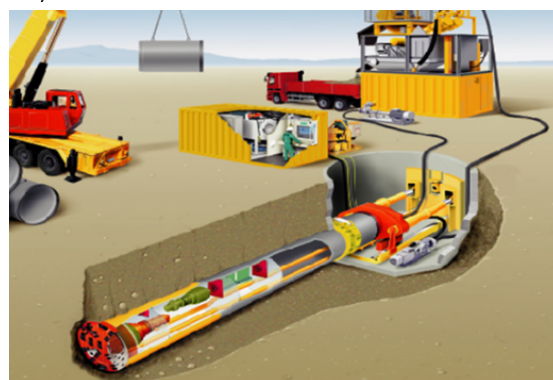
Hình 3.2. Thiết bị đào và kích ống được đưa xuống giếng kích [2].
