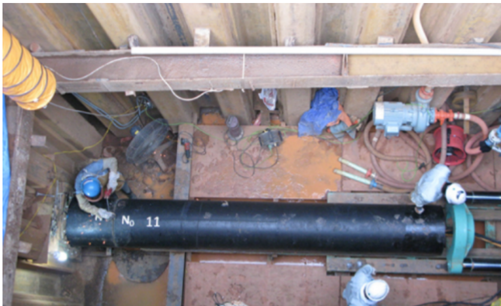
Hình 3.3. Ống được kích đẩy vào bên trong, xuyên qua đường [3].
